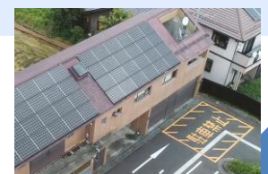
太陽光発電設備の設置
